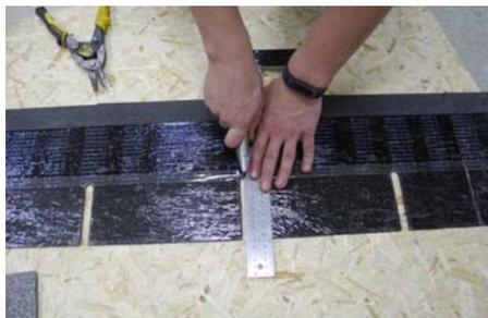
Рис. 6. Деление плитки на лепестки
